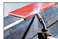
Закрепление с помощью сварки перфорированной стали
